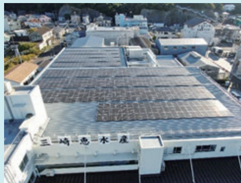
株式会社三崎恵水産社屋屋上の 太陽光パネル
