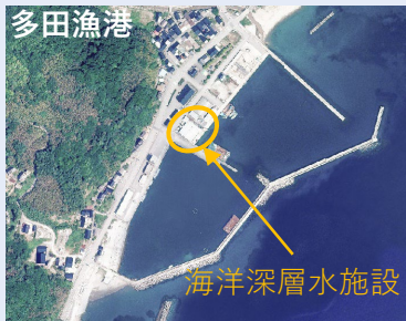
海洋深層水施設外観
