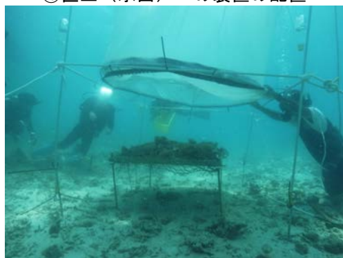
⑥架台の天端高と装置の底部の高さを調整
