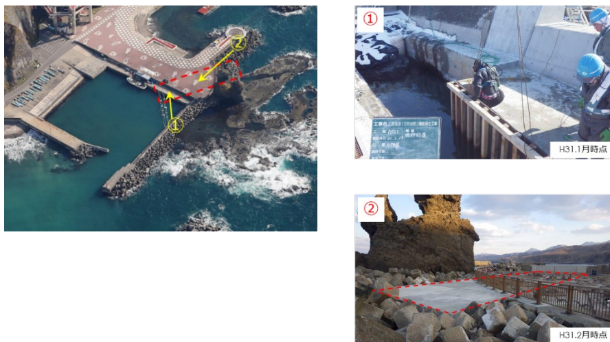
図 II. 3.6 施工状況 出典：北海道提供
