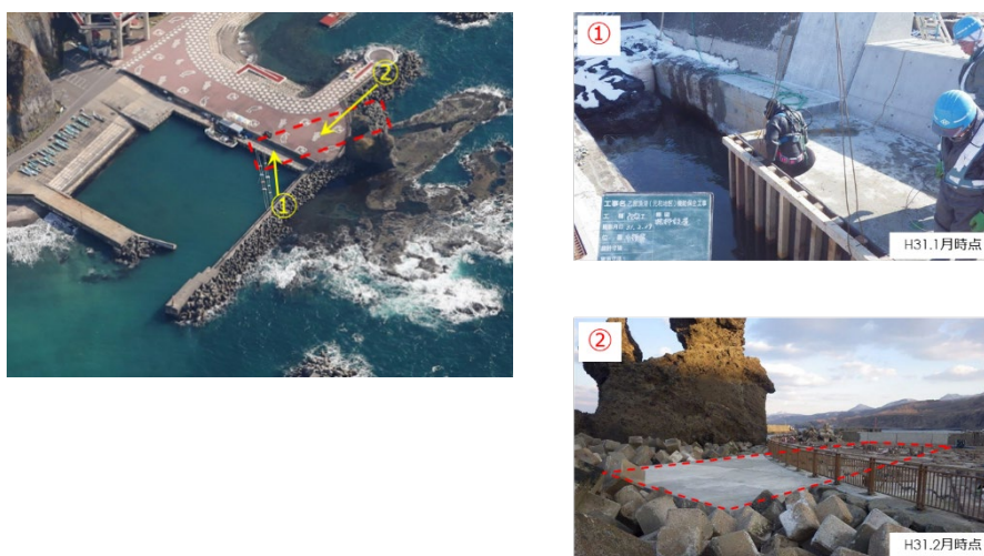
図 II. 3.6 施工状況 出典：北海道提供
