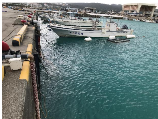
図Ⅱ.4.6 漁港内の取水場所
