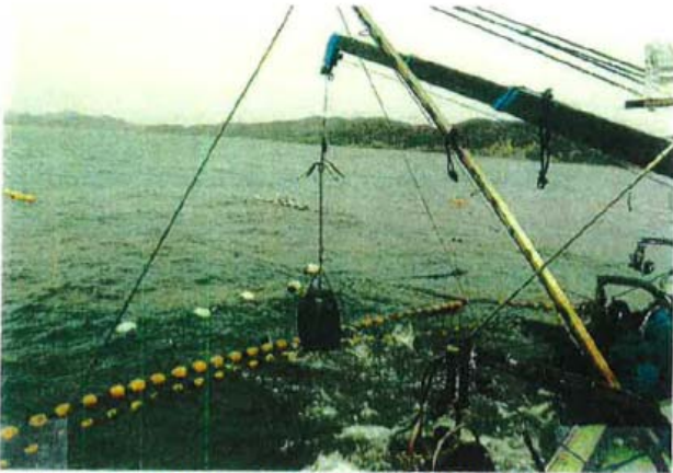
① ステンレスイカリにサンドバッグ500kgを取り付けクレーンで魚捕部へ。
